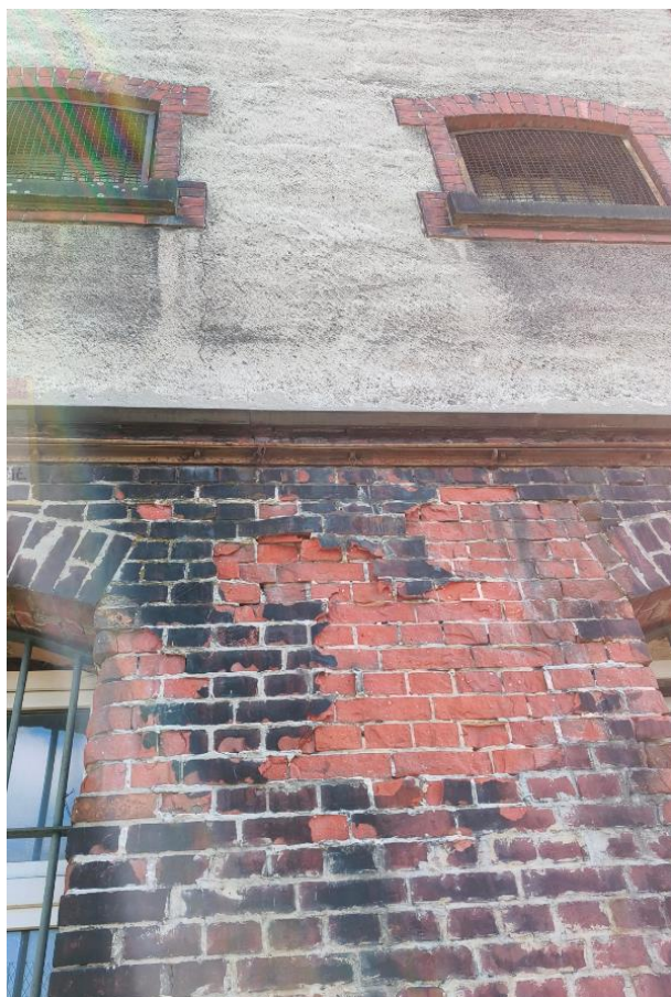
Fot. 1 Odpadnięte lica cegieł na elewacji zachodniej budynku
