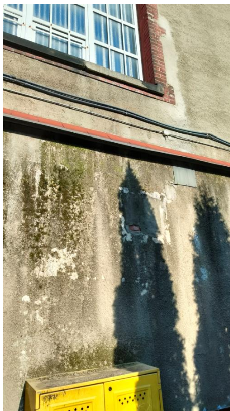
Fot. 5 Wtórne uzupełnienia tynku, korozja biologiczna w postaci mchu
