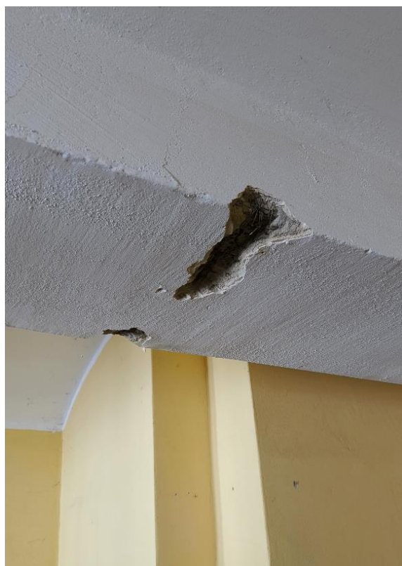
Fot. 15 Odkrywka podciągu stalowego w celi więziennej
