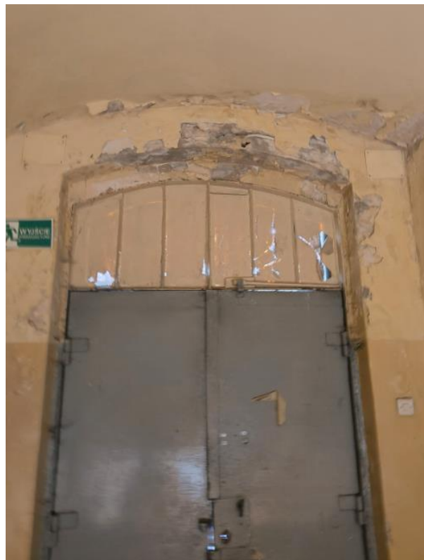
Fot. 8 Zawilgocenie, uszkodzenie tynku nadproża nad wejściem głównym do budynku
