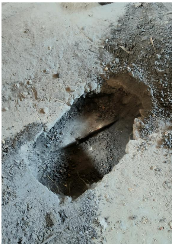
Fot. 17 Odkrywka stropu nad III piętrem (strop podstrychowy)
