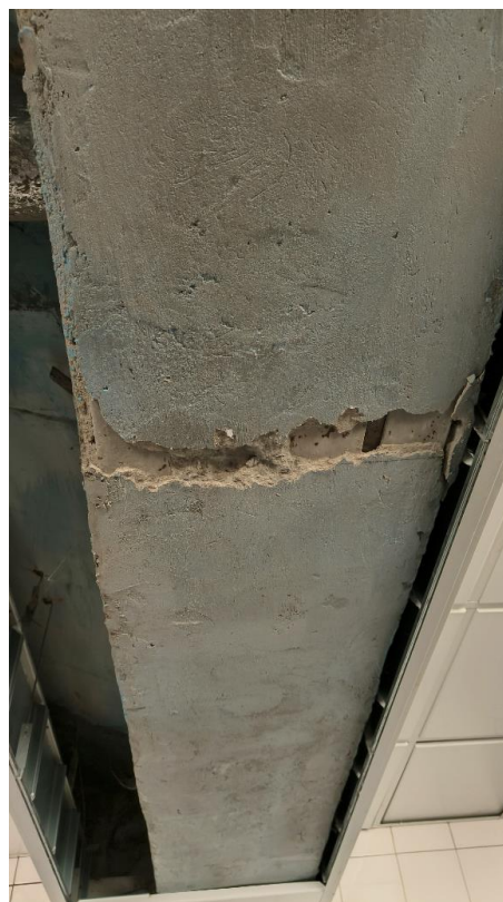
Fot. 12 Odkrywka podciągu stalowego
