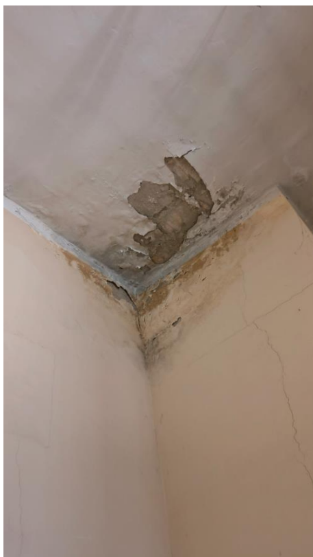
Fot. 7 Obfite zawilgocenie na suficie w rejonie komina
