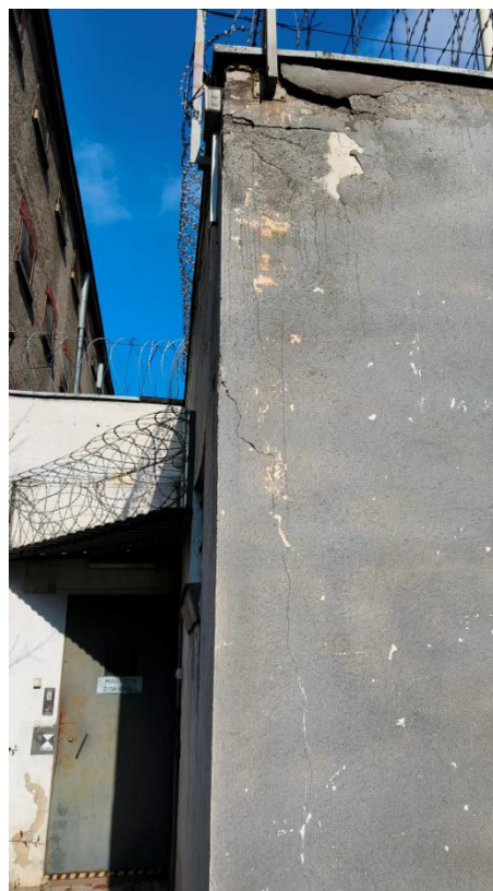
Fot. 6 Zarysowanie narożnika dobudowanej parterowej części budynku
