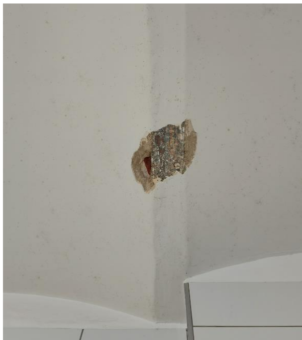
Fot. 11 Odkrywka belki stropowej stropu odcinkowego w północnym skrzydle budynku
