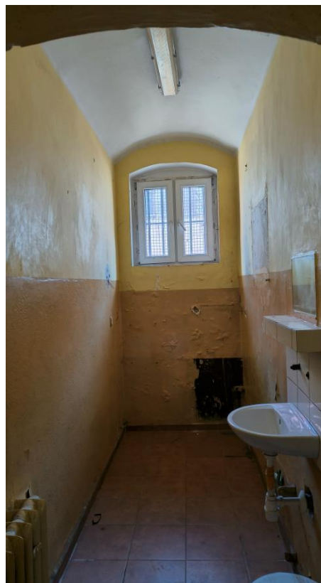
Fot. 10 Zawilgocenie w rejonie ściany zewnętrznej
