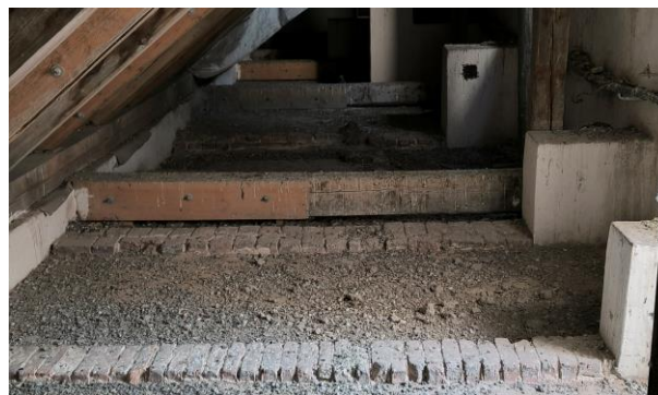
Fot. 18 Wtórne wzmocnienia więźby dachowej
