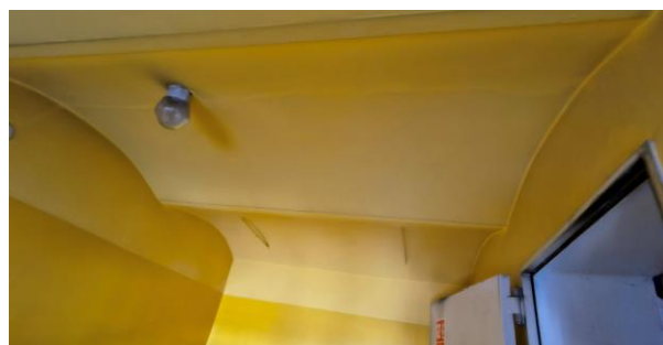
Fot. 16 Strop odcinkowy nad klatką schodową ze ściągami
