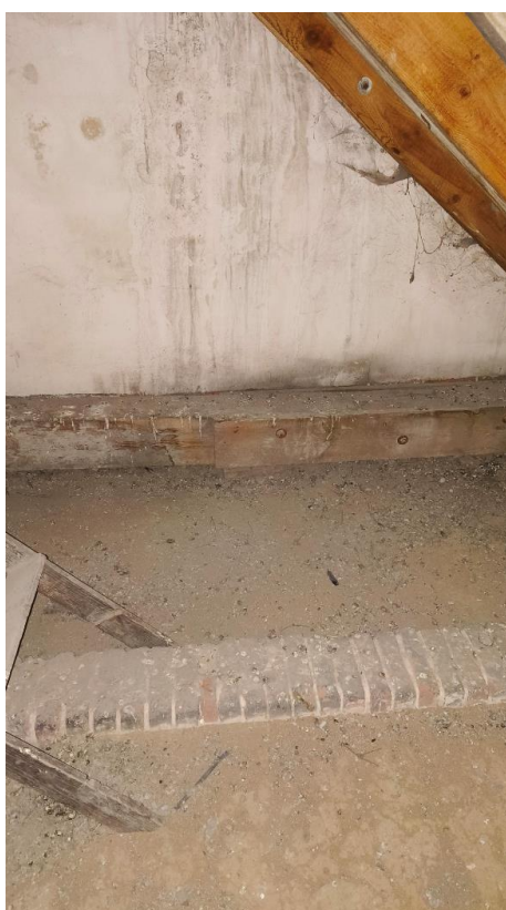
Fot. 19 Wtórne wzmocnienia więźby dachowej
